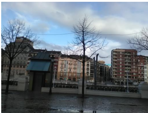
Catenaria formada por los cables de electricidad del Arenal
